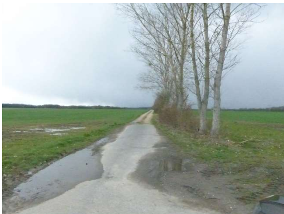
Feldweg im Süden des Plangebietes mit angrenzender Feldhecke, Blick vom Abzweig der S 122 in Richtung Südwesten
