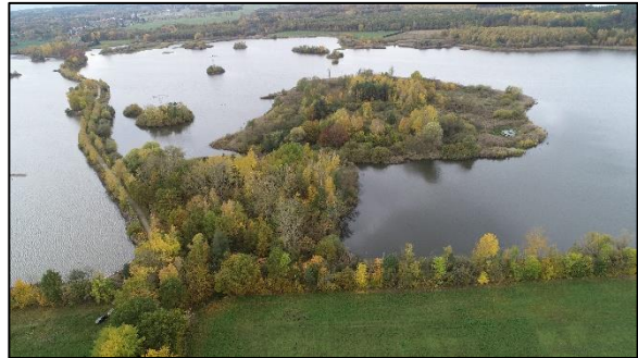
Talsperre Quitzdorf, Teilbecken Reichendorf
