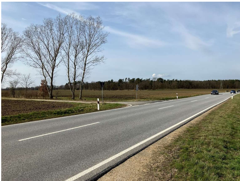
Foto: S 122 und Einmündung Wirtschaftsweg, die Staatsstraße begrenzt das B-Plangebiet im Osten
